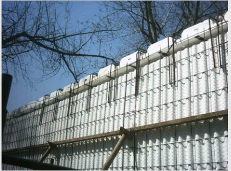
Losa de cubierta para terraza habitable
