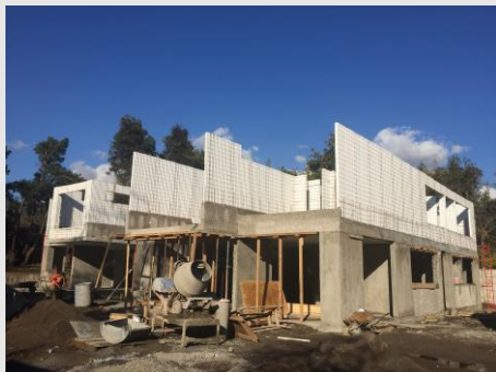
Viviendas en 2 pisos
