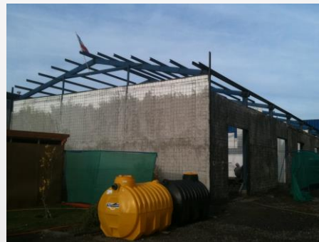
Cierre de galpones y muros cortafuego
