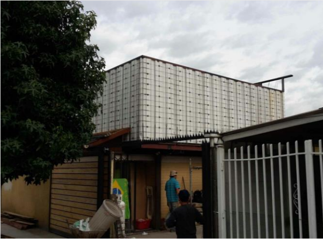
Ampliación 2do piso
