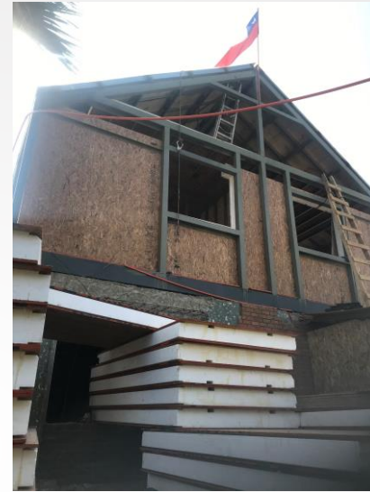
Construcción segundo piso
